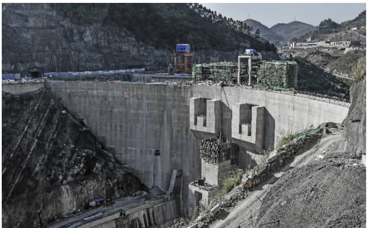
兴义马岭水库是国家发改委重点支持的重大水利工程之一,是一座主要解决城乡供水、农业灌溉并兼顾发电的大型水库。工程于2015年开始建设,概算投资23.2亿元,总库容1.32亿立方米,水库正常蓄水位1030米,正常蓄水位库容1.2亿立方米,兴利调节库容1.072亿立方米,坝高90米。目前,大坝建成,开始安装闸门,预计今年4月下旬蓄水。图为马岭水库大坝。 记者 邢贵龙 摄
